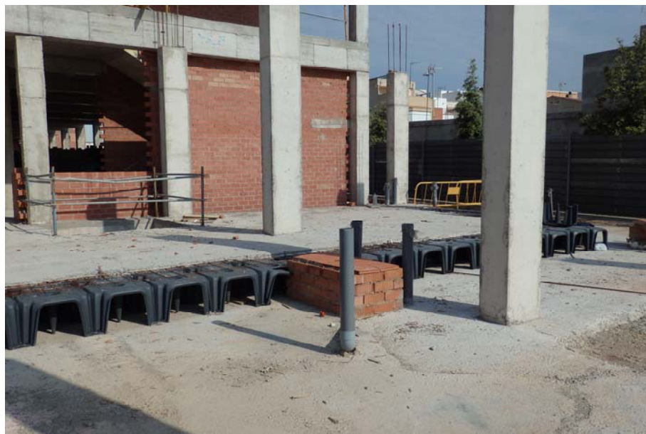
Vista del forjado sanitario por finalizar del edificio de primaria.
