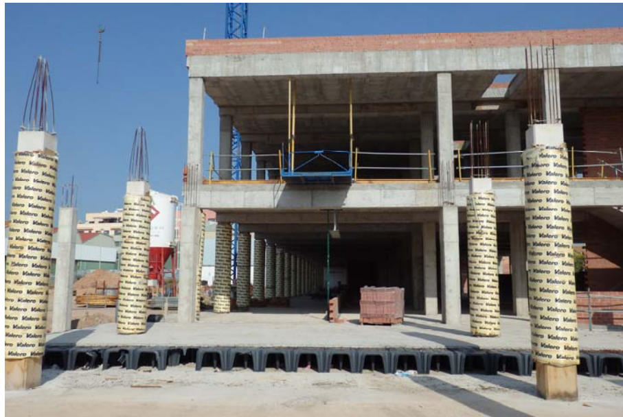
Vista del edificio de primaria.
