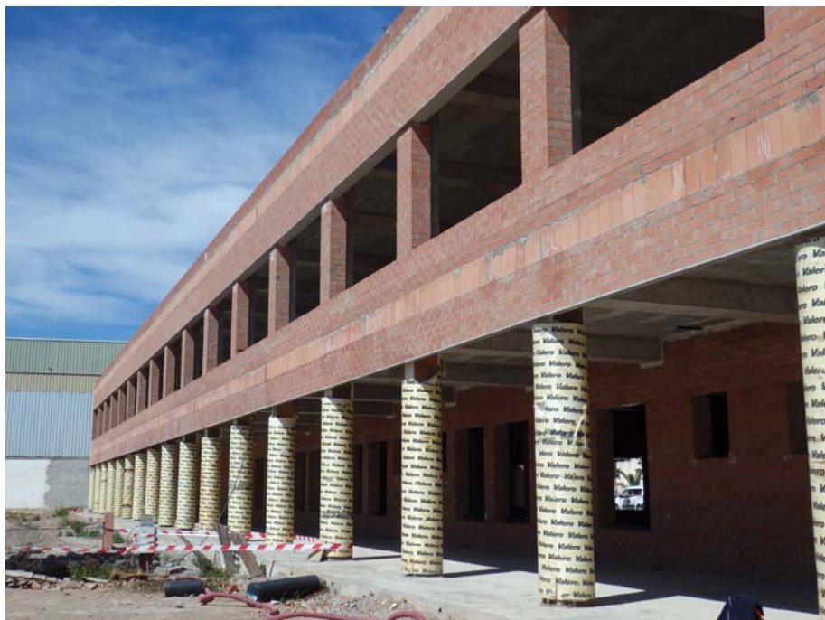
Fachada interior del edificio de primaria. Vista del porche.
