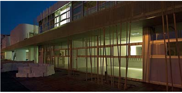
Colegio Público La Condomina, Playa de San Juan. Alicante La Condomina Elementary School, Playa de San Juan. Alicante
